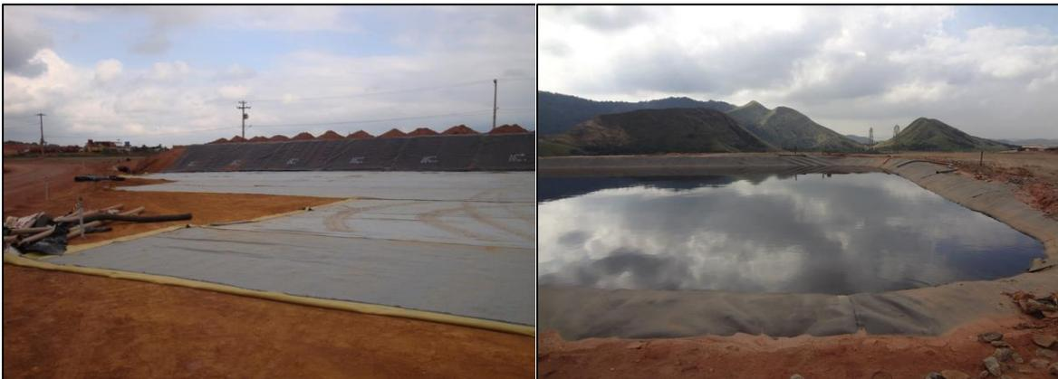
Figura 6.22: Manta geotêxtil de cobertura e lagoa de chorume do CTR – Seropédica.
