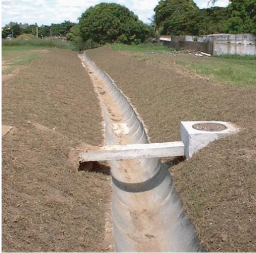
Figura 12 - Canaletas Semicirculares em Concreto
