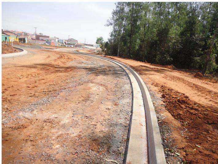
Figura 22 – Sarjeta de Concreto em construção
