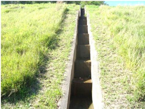
Figura 13 - Canaleta Retangular em Degraus
