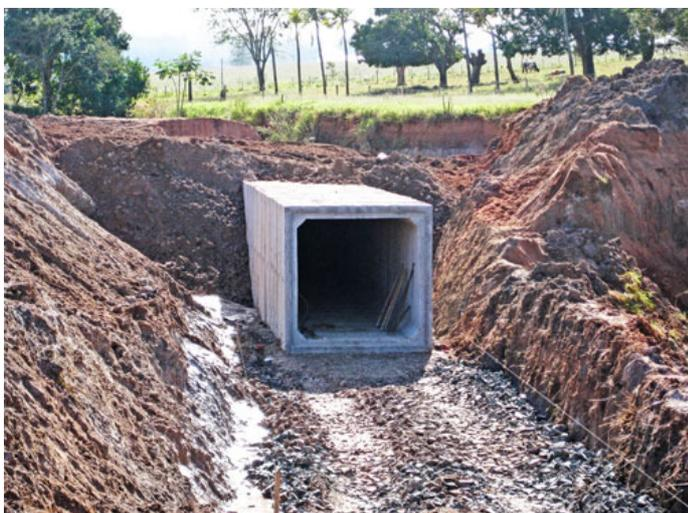
Figura 17 – Galeria Retangular em Concreto
