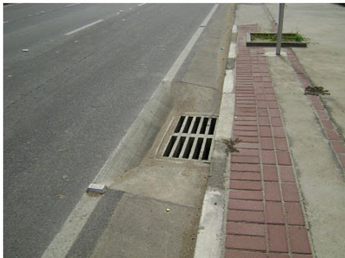
Figura 23 – Sarjeta de Concreto construída
