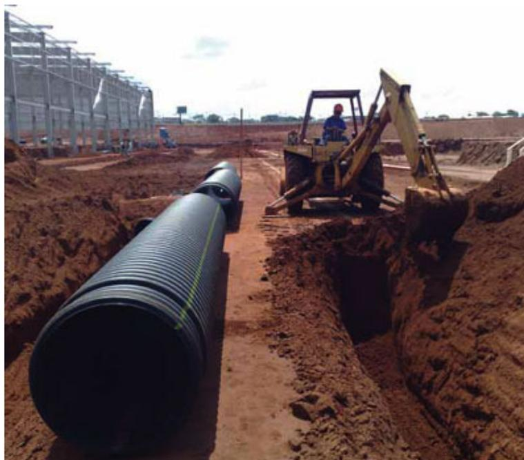
Figura 19 – Aplicação de Tubos em PEAD para Drenagem
