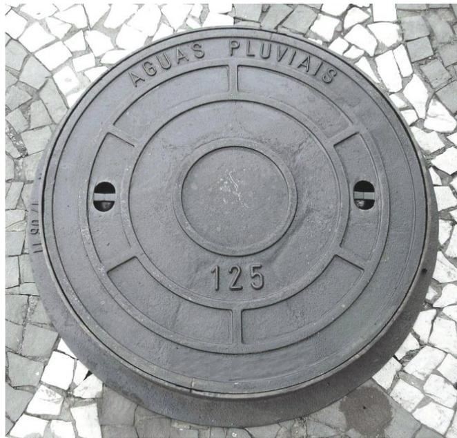
Figura 26 – Tampão de Ferro Fundido para Águas Pluviais
