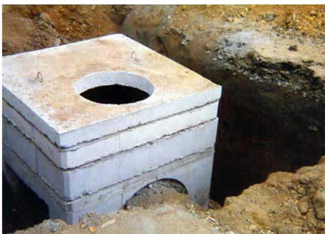
Figura 25 – PV construído cm peças pré-moldadas
