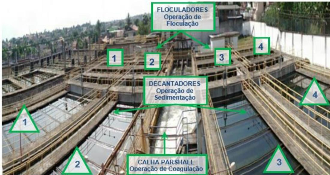
Figura 15 - Unidades da ETA n°1 onde são realizados os processos de coagulação, floculação e decantação
