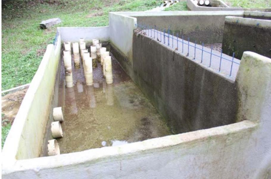
**Figura 32:** Filtro Anaeróbio e Vertedor do TD (fora de operação).
