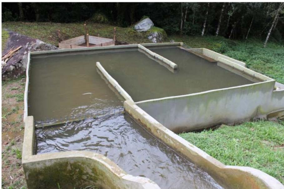
**Figura 29:** Tanque de Decantação (TD).
