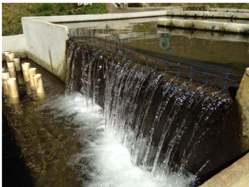
**Figura 30:** Vertedor do TD em operação.
