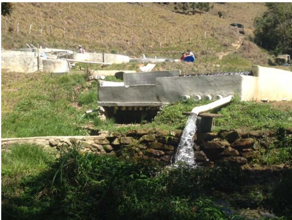
**Figura 33:** Desvio do efluente tratado para a área pantanosa e Vista lateral da estrutura implantada (TD em associação ao Filtro Anaeróbio).
