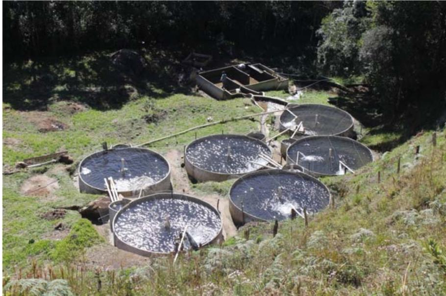
**Figura 28:** Sistema de Produção do Empreendimento Trutas da Lapa. Ao fundo, Tanque de Decantação e Filtro implantados no âmbito do Sistema de Tratamento de Efluentes.
